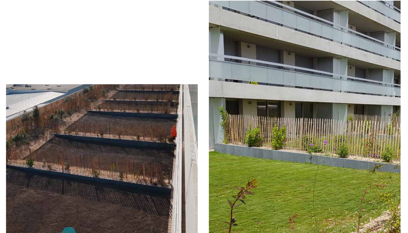
Mise en place de murs en L sur l'Attique de Brienne à Bordeaux
